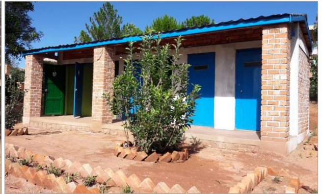
Construction de nouveaux sanitaires pour l'école, entre septembre et décembre 2020. Le bâtiment est terminé !
